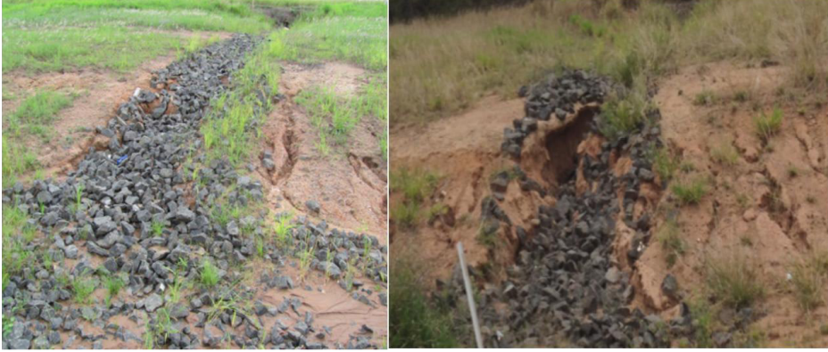
Şekil 1: Sınırlı Kaya Örtüsüne Sahip Dağınık Kumlu Toprakta Oluşan Bir Drenajın İlerleyen Erozyonu- İlk Erozyon (Solda) ve Artan Kesik (Sağda).
