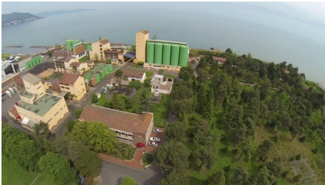
Şekil 8. Fındık Yağı Sanayi Fabrikası (URL-7, 2020)
